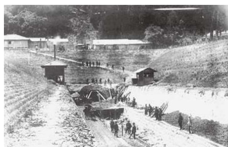
建設当時の様子
