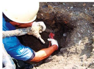
▲ 鉛製給水管取替工事
